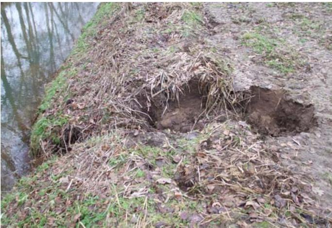
Abbildung 14: Nutriaschäden und -schäden, Molkereigraben bei Neuhaus-Veldhausen (2018)
