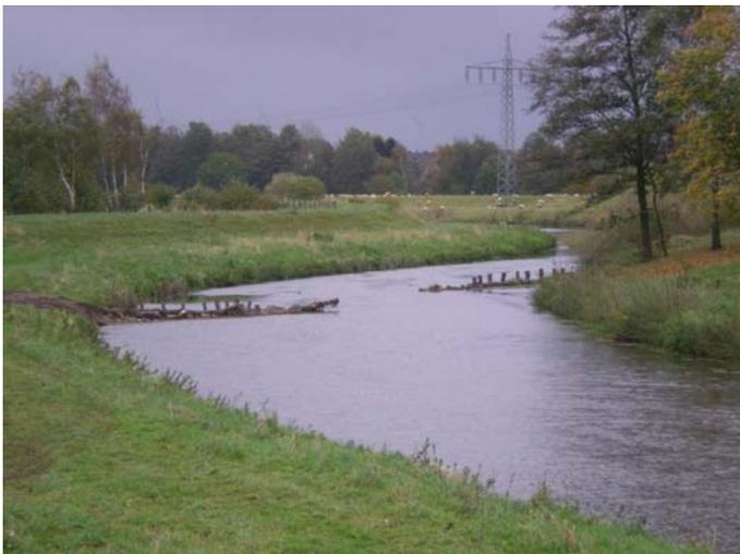
Abbildung 16: Totholz-/Kieseinbau zur eigendynamischen Entwicklung bei hydraulischen Reserven, mit Anpassung der abflusssichernden Maßnahmen, Hase bei Bramsche (2017)
