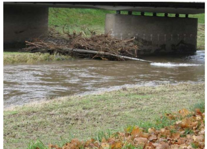
Abbildung 11: Teilverklauserung an einer Brücke, Rhume bei Bernshausen (2019)
